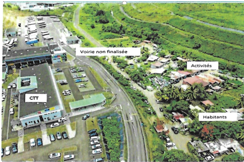
FIGURE 2 : PHOTO AERIEENNE DU PERIMETRE DE LA RHI TROMPEUSE DEVANT ACCUEILLIR LES L.E.S
